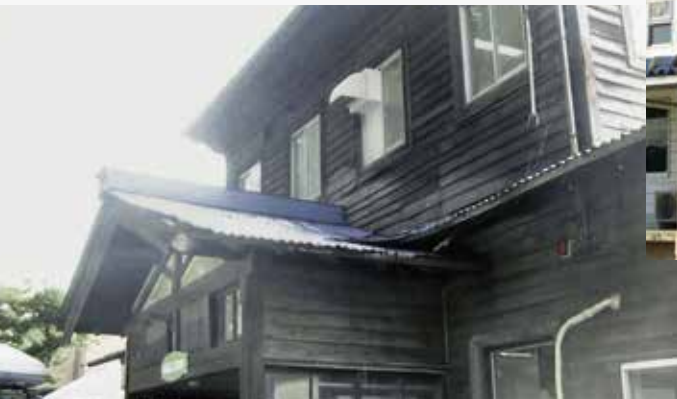
旧ガリウム工場(秋田県小坂町・明治38年建造)
