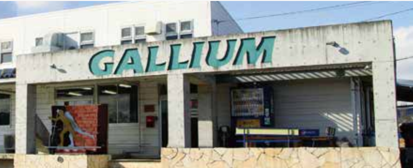
現ガリウム工場(宮城県仙台市)
